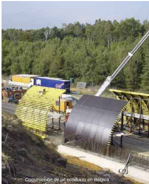
Construcción de un ecoducto en Bélgica
